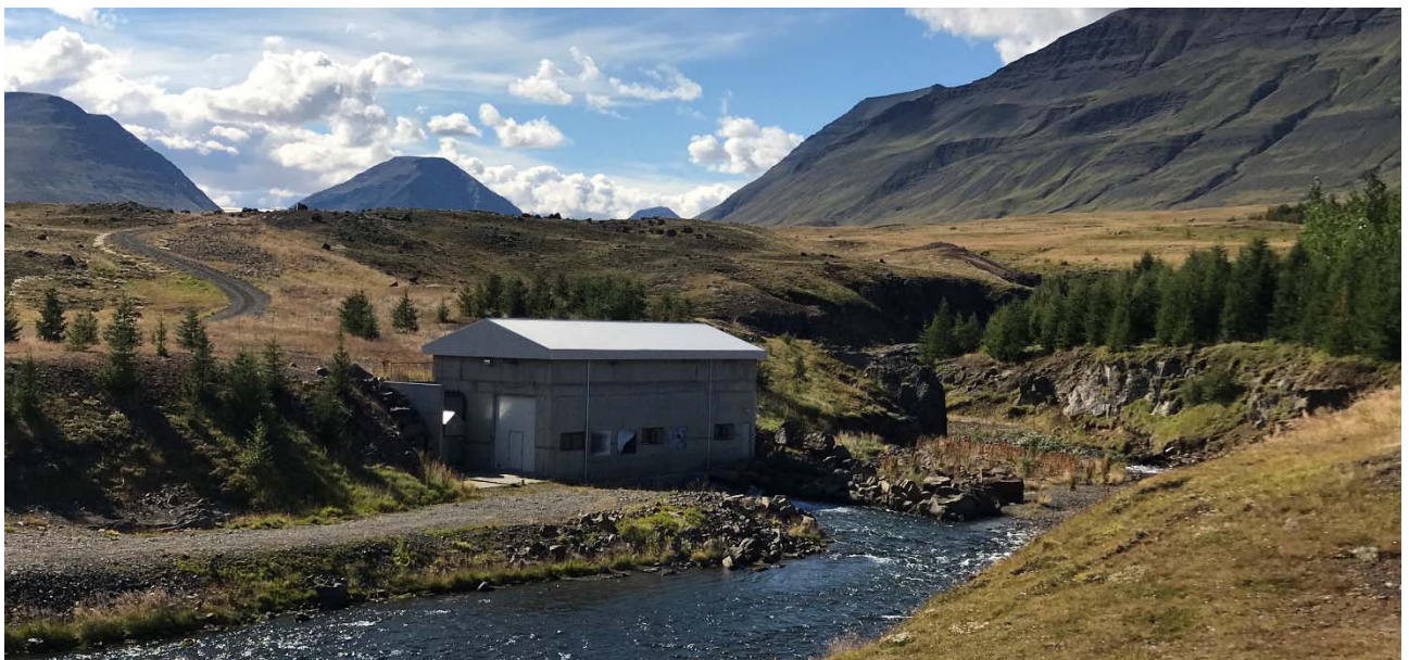
Mynd 4. Stöðvarhús Djúpadalsvirkjunar I.
