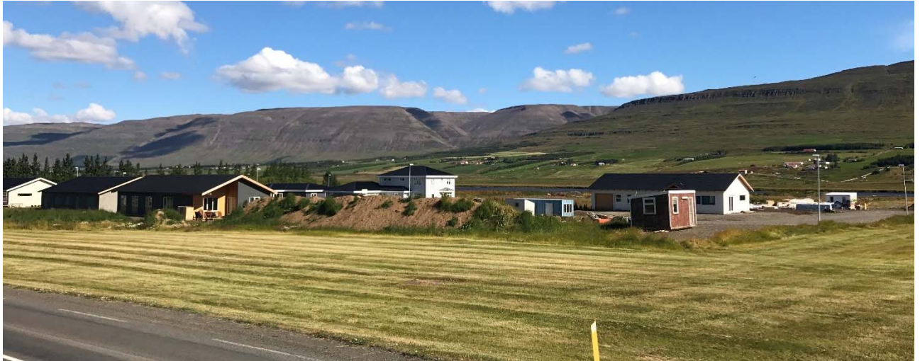
Mynd 2. Íbúðarsvæði 1B5 í Hrafnagilshverfi í uppbyggingu.
