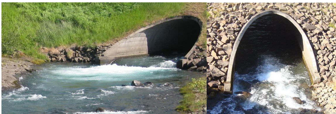
Mynd 4.2.2.11: Ræsi undir Þjóðveg.
